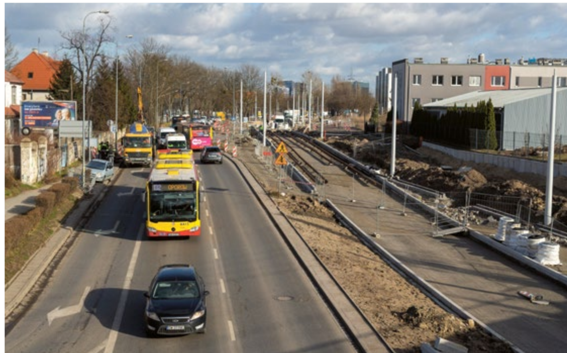
W ciągu ul. Strzegomskiej budowane jest torowisko, dojedziemy nim tramwajem na Nowy Dwór
